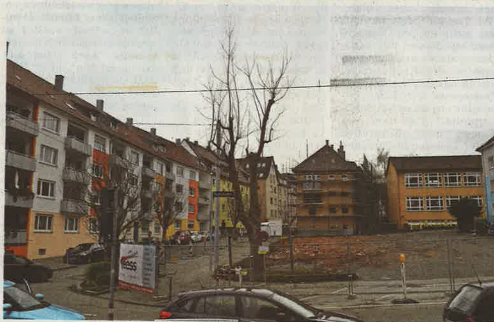
Im April sollen hier die Bauarbeiten für das Jugendwohnheim beginnen.
